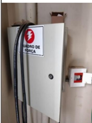
Sistema de fornecimento: 02(dois) nobreaks (UPS) 20 KVA, Marca PHD, com 32 baterias internas e quadros de comando e revezamento, sensores e correlatos a este sistema.
